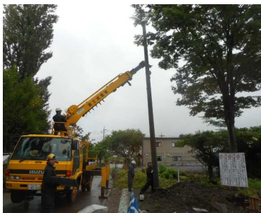
引込開閉器盤据付
